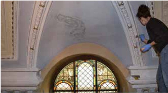
Restauratorin bei der Arbeit, Oktober 2019, Foto: Bernd Baldszuhn
