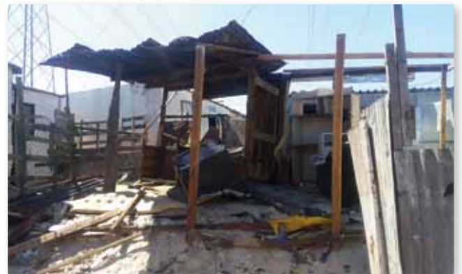
Ein Leben auf Sand gebaut in Kapstadt, Südafrika. Die drei Geschwister, die dort wohnen, freuen sich über eine neue Wellblechhütte. Sie sind glücklich, dass das lokale Projekt „Child-headed household“ sie unter so vielen ausgewählt hat, ihnen ein bisschen zu helfen.
